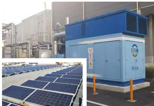
ワタキューセイモア株式会社東京支店相模原工場では、生産設備や照明に関する省エネルギー対策を継続的に実施しており、さらなる推進のため、省スペースなシステムと設置レイアウトを最適化することでコージェネレーションシステムの導入を実現した。既存の太陽光発電設備と組み合わせた電源の多様化により、電力コストを削減するとともに、系統電力停電時の事業継続性の向上も図っている。
