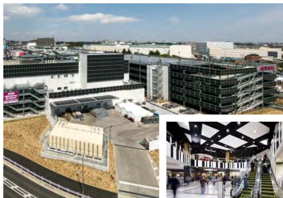
平成30年3月に開業したイオンモール座間において、大規模な太陽光発電設備、ヒートポンプ式空気調和設備、電気自動車充電設備（10基）、全館LED照明設備の設置など、エネルギー使用の合理化や設備システムの高効率化を図っている。
