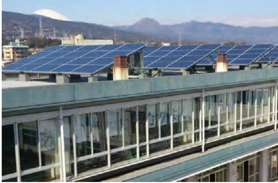
小田原市立小学校7施設に蓄電池及び太陽光発電を設置し、市立の幼稚園、小中学校42施設に地産電力を含む電力を供給している。また、蓄電池の遠隔制御によりエネルギーマネジメントを行っている。
