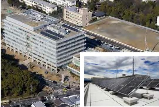
平成29年12月に完成した新庁舎において、太陽光発電設備、ガスコージェネレーション設備、自然換気装置、氷蓄熱型空冷ヒートポンプ、電気自動車充電設備（3基）、LED照明設備の設置など、自然エネルギーの有効活用や設備システムの高効率化などを図っている。
