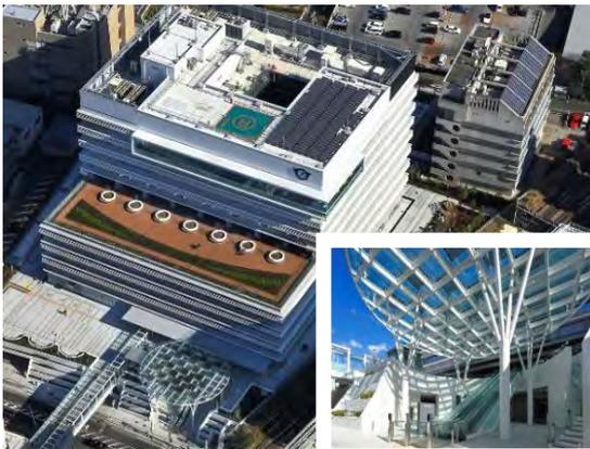
平成29年12月に竣工した藤沢市新庁舎において、太陽光追尾システムによる自然採光や自然換気システムのほか、太陽光発電設備（屋上、屋上ルーバー、サークルプラザ屋根）、ハイブリッド外灯（風力、太陽光）、ガスコージェネレーション設備の設置、空冷式高効率ヒートポンプの採用など、自然エネルギーの有効利用や設備システムの高効率化を図っている。
